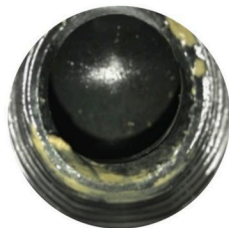
Après Installation HOMEO DEKALC
